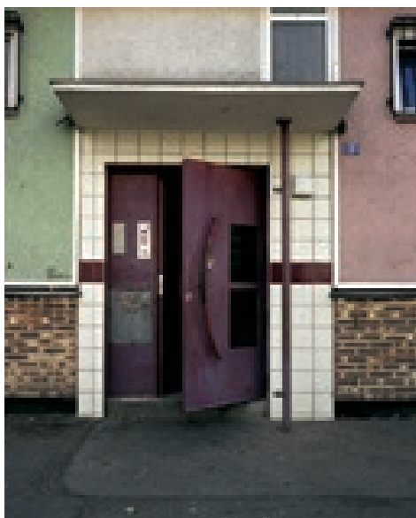
Entrée d'immeuble, Bobigny. 2006
